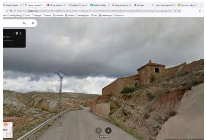
Foto 2. Línea de media tensión que llega la municipio.
