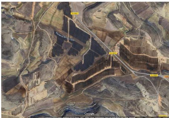
Foto 7. Parque fotovoltaico 'La Estación' en Cañada Vellida.
