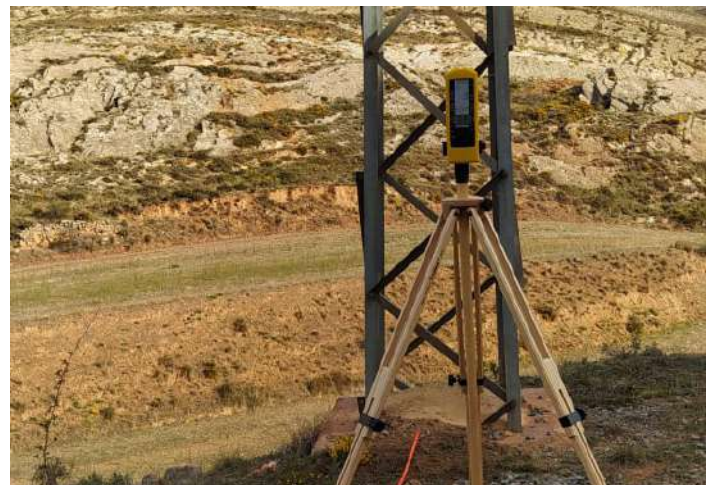
Foto 4. Medición a pie de la torre de media tensión.
