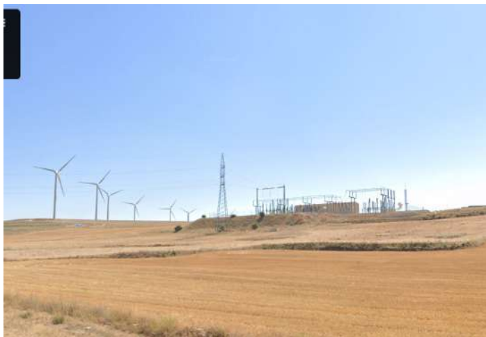
Foto 11. Subestación eléctrica 'Montesol' en Cañada Vellida.
