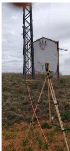
Foto 19. Medidor a 4 metros de la torre de media tensión.
