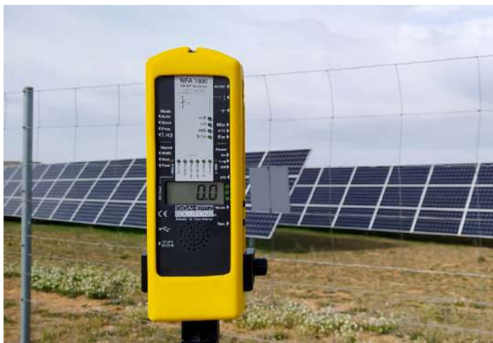
Foto 9. Medición de campo eléctrico alterno cerca de la valla.
