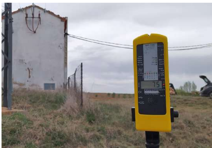
Foto 21. Medición de campo magnético alterno cerca de la torre.
