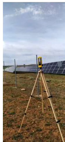
Foto 8. Medidor en trípode cerca de la valla del parque fotovoltaico.
